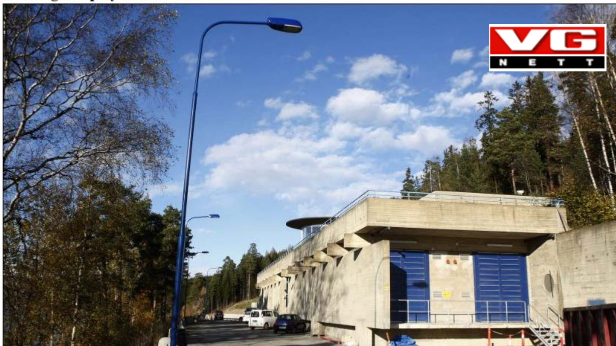
RENSEANLEGG: Oset vannbehandlingsanlegg og andre bygg som er kritiske for vann- og avløpsnettet i Oslo kunne inntil i vår åpnes ved hjelp av blåtannteknologi. Foto: Heiko Junge / SCANPIX .
