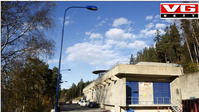
RENSEANLEGG: Oset vannbehandlingsanlegg og andre bygg som er kritiske for vann- og avløpsnettet i Oslo kunne inntil i vår åpnes ved hjelp av blåtanteologi. Foto: Heiko Junge / SCANPIX.
