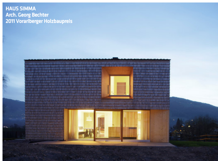
HAUS SIMMA Arch. Georg Bechter 2011 Vorarlberger Holzbaupreis http://www.architonic.com/aisht/house-simma-georg-bechter/5101226
