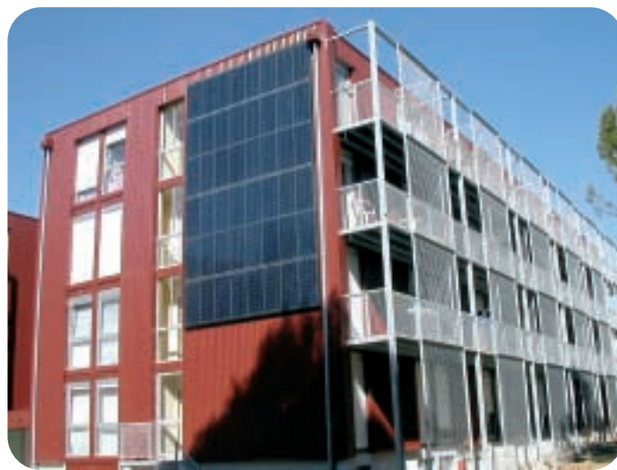
Panneaux photovoltaïques et balcons avec treillis pour plantes grimpantes
