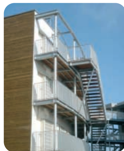
Utilisation d'acier galvanisé et de bardage bois
