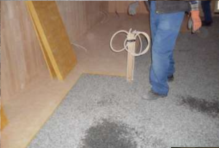
Montering av lydisolerende pukklag
