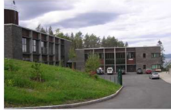
Slambygge og administrasjonsbygg
