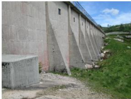
Avstiving med isolasjonsvegg
