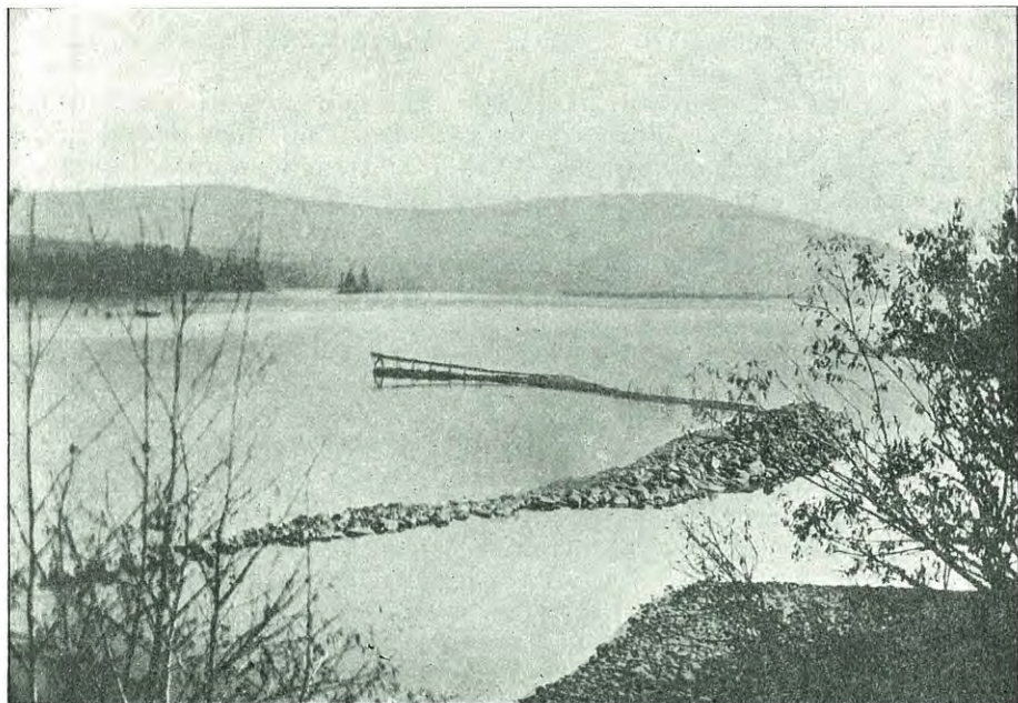
Fig. 18. Stengard til at inddra noten paa ved Kolbergstue-varpet
