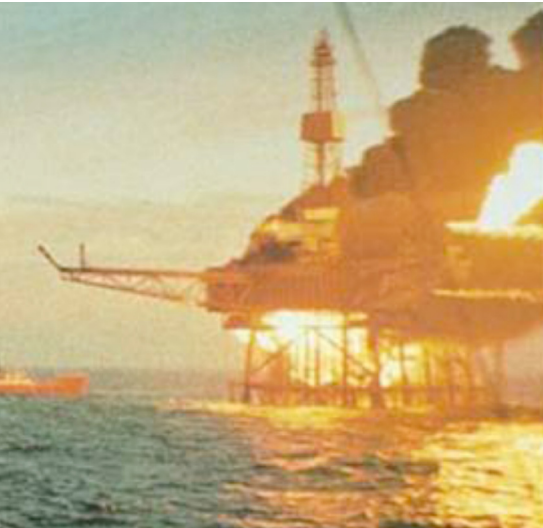
Piper Alpha i en kritisk fase av brannen. Fra [10.7] Brannen eskalerte voldsomt da store gass-stigerør brast, noe førte til utstrømning av flere tonn gass per sekund
