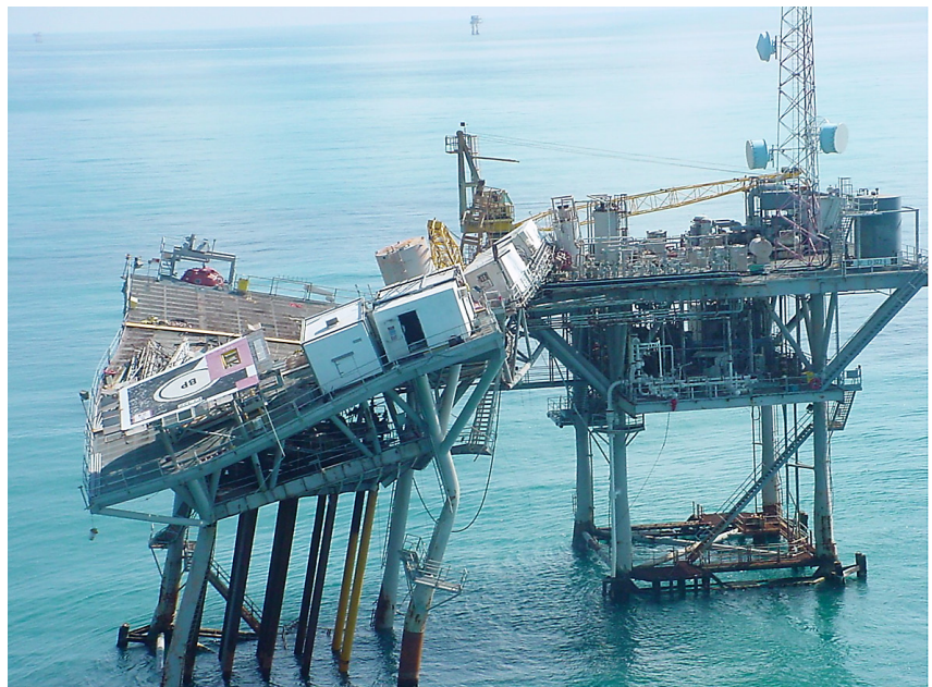
Plattform i Mexico-gulven, etter orkanen Lili (oktober 2002), vindstyrke 65 m/s, bølgehøyde 17 m. Her har ikke materialene hatt tilstrekkelig styrke, og plattformen i forgrunnen har totalhavareert.
