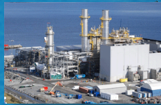
Prosessanlegg på land
