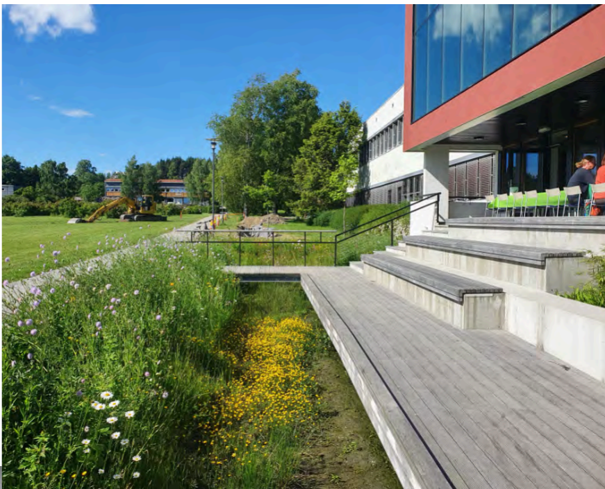
Sittetrinn med treavdekning ned fra kantineplass ved TF-bygget ved NMBU på Ås. Foto: LINK Arkitektur
