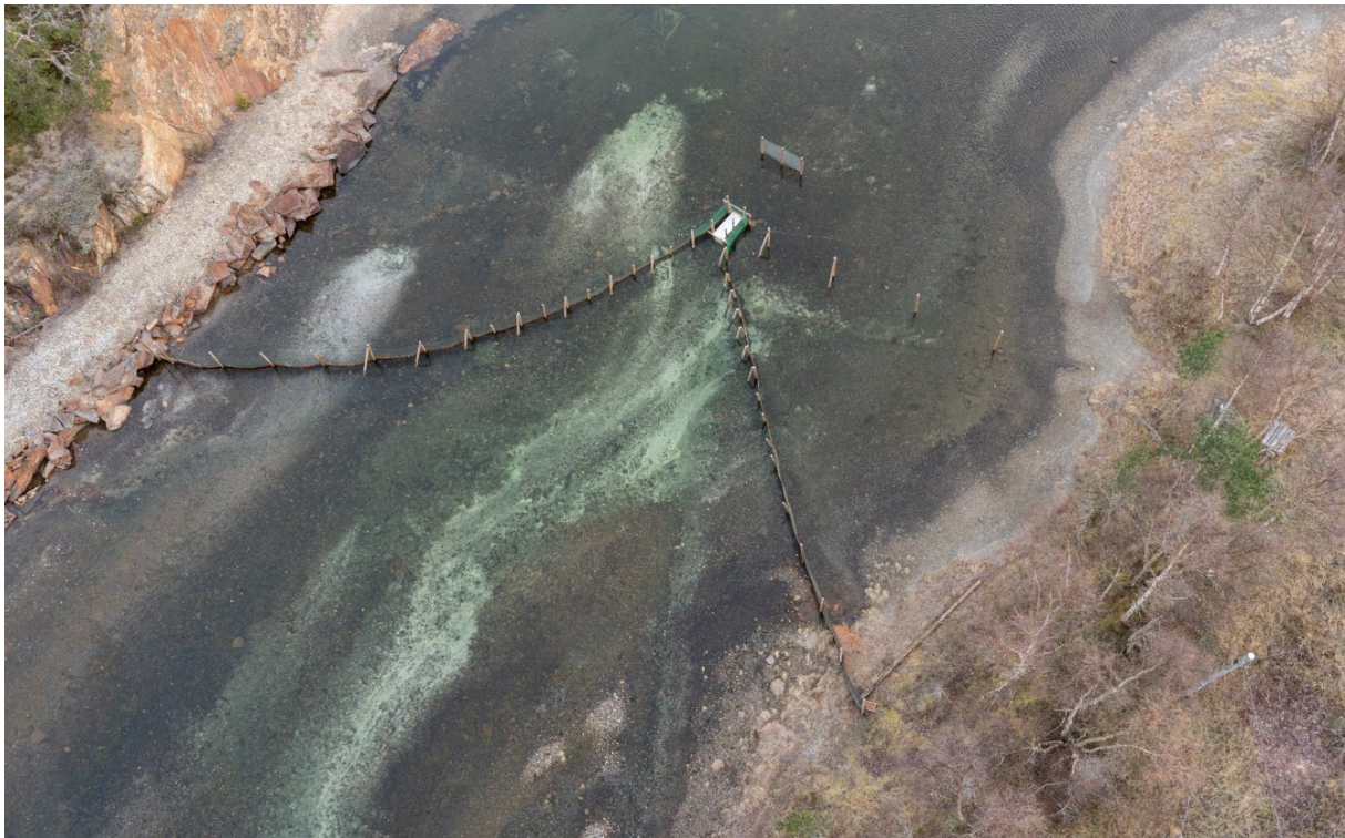
Bilde: Dronebilde av ledegjerdet og videotunnel på utløpet av Litjvatnet. Foto: Per Gätzschnann.
