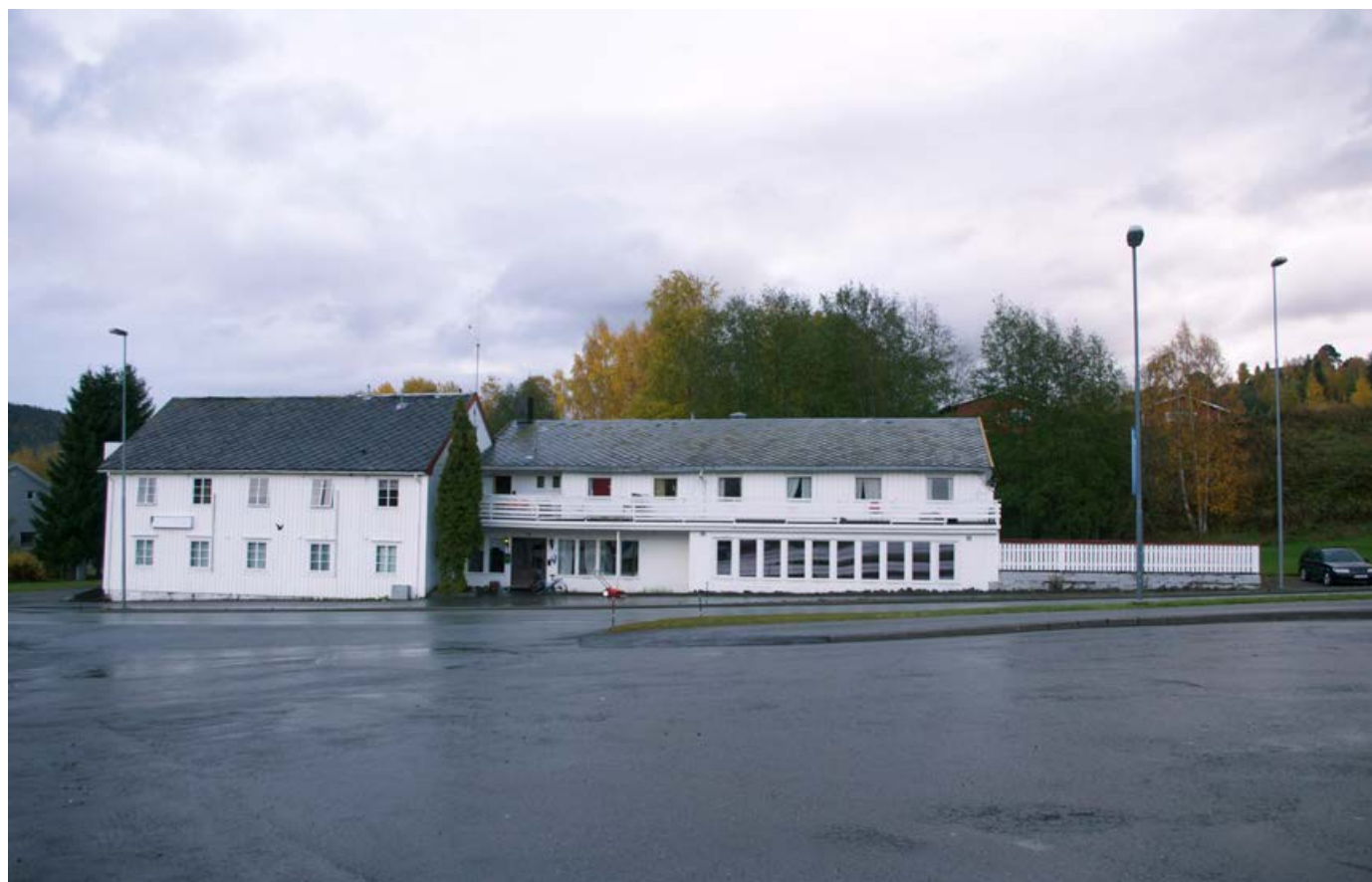
Det er en stor variasjon av bygningstypologier og omgivelser som brukes til asylmottak. Her et nedlagt hotell. A wide variety of building types are used as reception centres. Here a former hotel.
