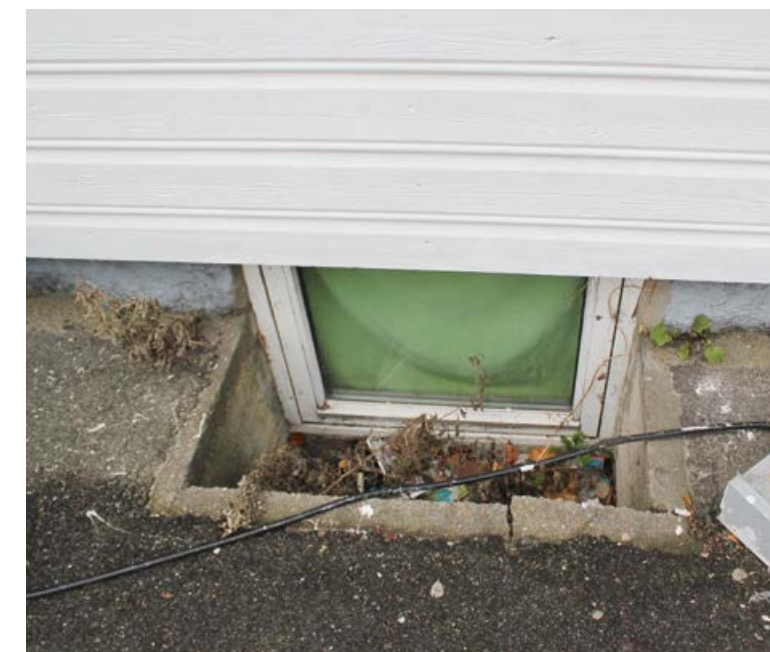
Manglende dagslys på soverom. Lack of daylight to bedroom. Foto: Karine Denizou
