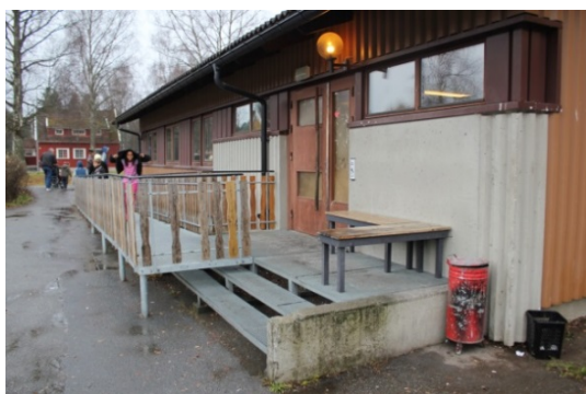
Tilrettelegging av inngangsparti og atkomst for rullestolbrukere er et av tiltakene for å øke tilgjengeligheten som utføres på mottak. Foto: SINTEF Byggforsk
