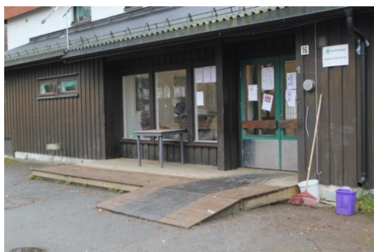
Tilrettelegging av inngangsparti og atkomst for rullestolbrukere er et av tiltakene for å øke tilgjengeligheten som utføres på mottak. Foto: SINTEF Byggforsk
