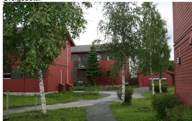
Eksempel på bygninger bygd for å være sentralisert mottak i 1990 i en by i midtnorge. Mottaket består av seks bygninger, alle laget av brakkemoduler. Foto: Eli Støa
